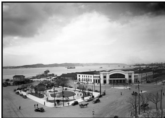
Cais do Sodre 1950
